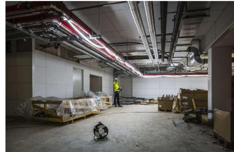
Das **FLEXblue System** ist modular aufgebaut und damit sehr flexibel. Es kann im Rahmen der Systemlänge beliebig mit LED-Lichtbändern je nach Baufortschritt erweitert werden.
